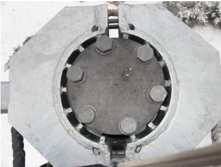
Bild III/6.3.1.4-2 gezahnte Stahlschelle
