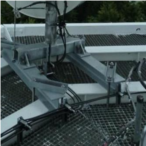
Bild III/6.11.4; 1-2 Spiegelhalterung auf Stahlunterkonstruktion einer Plattform
