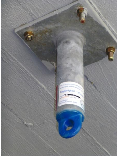
Bild I/3.5.1-1 DFMG: blau gekennzeichnete ASE
