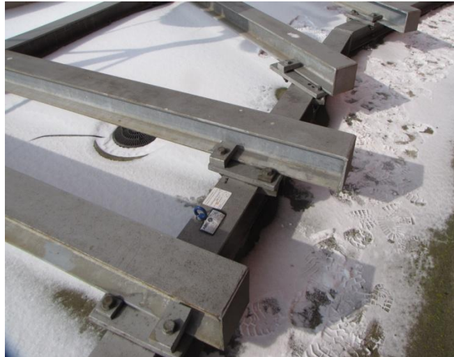
Bild III/6.11.4; 1-2 Spiegelhalterung auf Stahlunterkonstruktion einer Plattform
