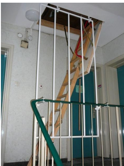
Bild I/3.6.3.3-3 DFMG: Treppenauge Absturzsicherung
