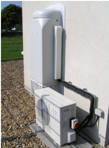
Bilder I/17.3.2;1-2 Cool Flow Gerät mit Kälte an einem Betoncontainer und an einem GFK Container montiert
