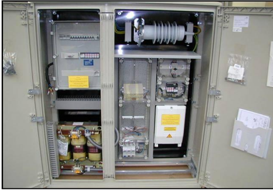
Bild II/4.3-1 DFMG: Trenntrafo
