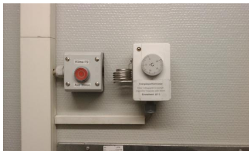
Bild I/17.2.1.4-1 DFMG: YT-Ausschaltthermostat
